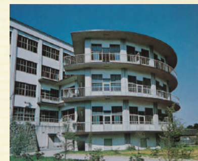
昭和39年に竣工した九州女子大学新館
