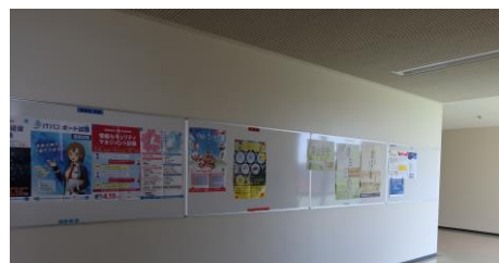
壁の塗り替え、掲示板増設
